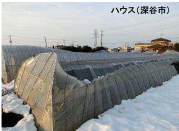
ビニールハウスの被害
