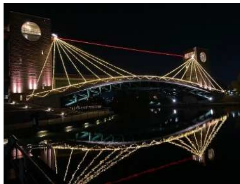
【富岩運河環水公園・天門橋】
